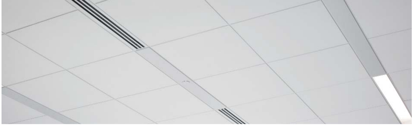
Plafones de sitio Optima de 30" x 30" con plafones técnicos metalicos de 6" x 60".
