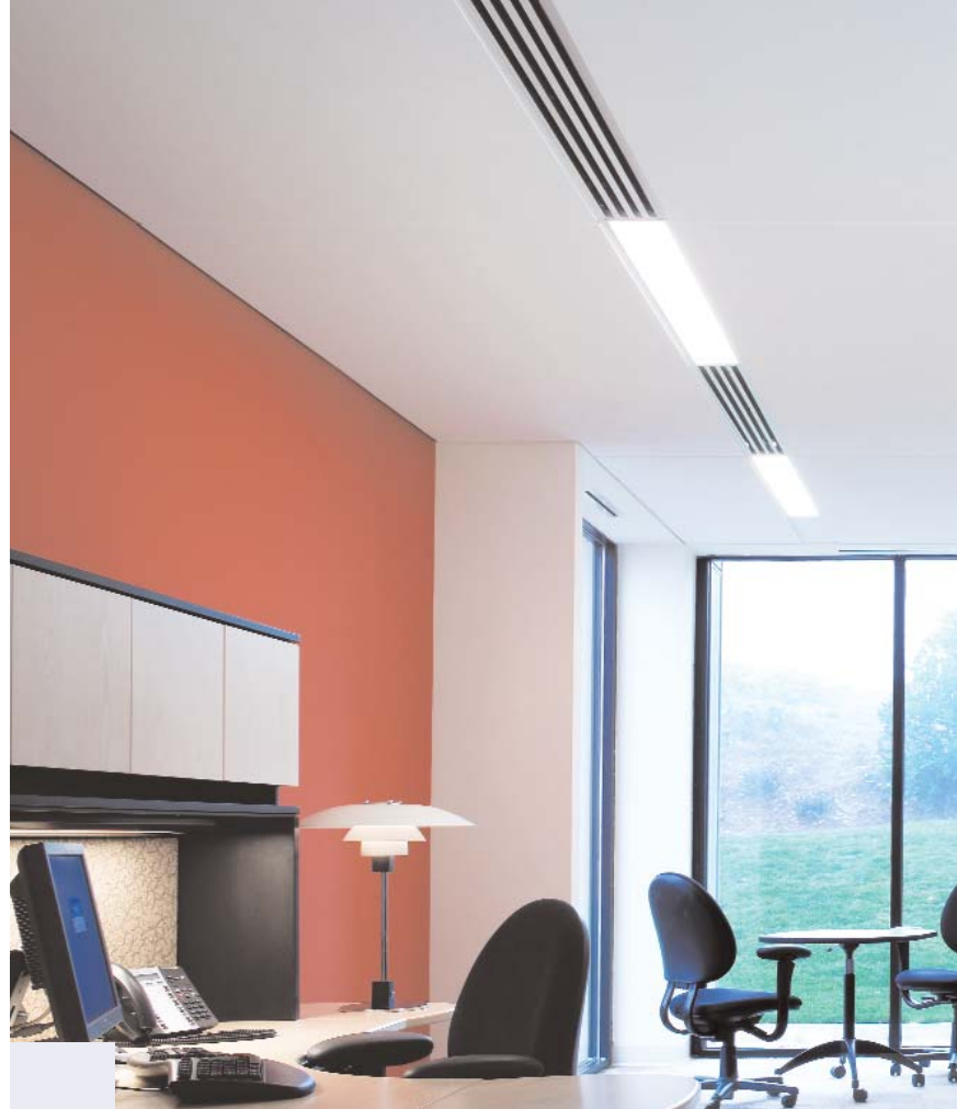
Plafones de sitio tegulares Optima de 48" x 48" con plafones técnicos tendidos metalicos de 6" x 48".
