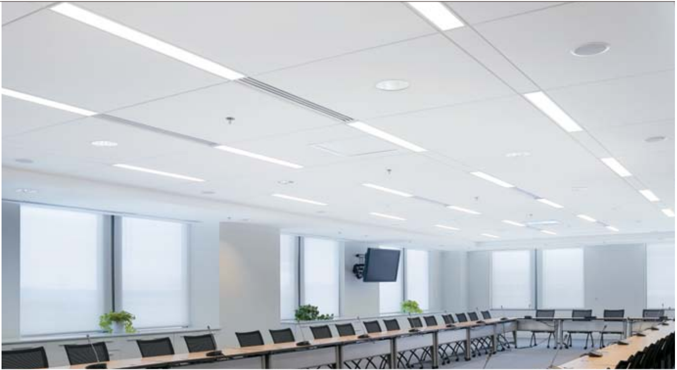
Sistema de plafones (cielos rasos) TechZone con plafones Optima® de área de 48" x 48" y plafones técnicos de 6" x 48"
