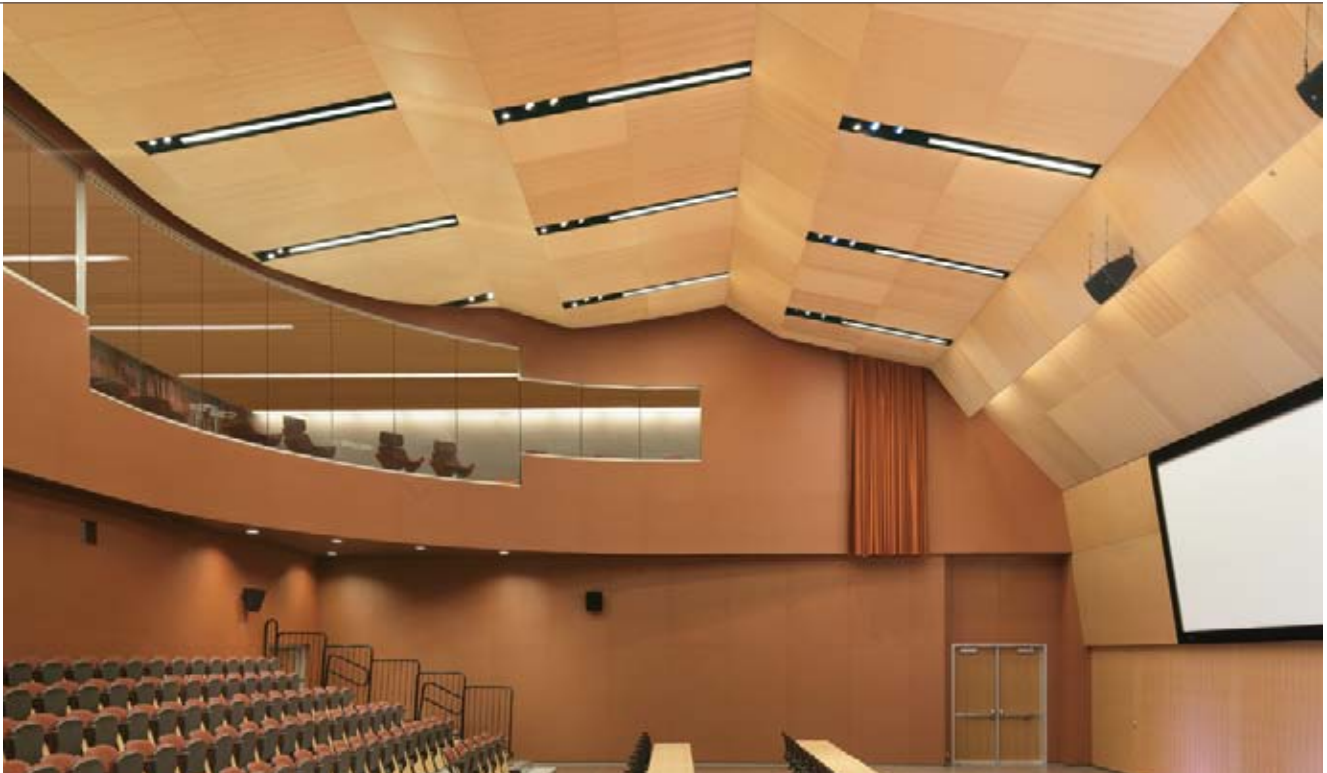
Tamaños variados MetalWorks Resortes de Torsión con perforación M15 en PureWood™ Natural Variations™ Maple en sistema de suspensión Prelude® de 15/16"
