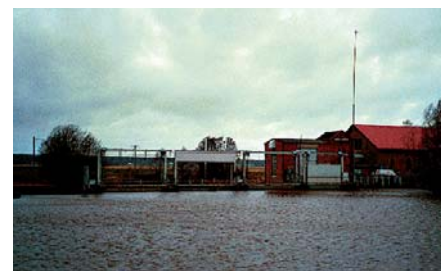
Tidevad, Sweden • Installer: Olab AB.
