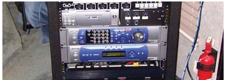
Atlas Rack Loaded with AV Equipment
